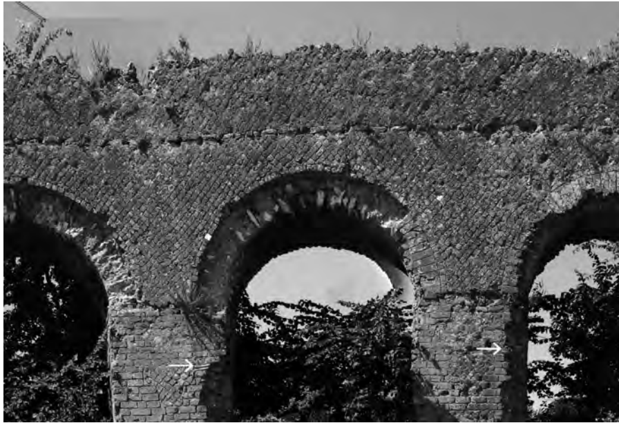
15. Ziegelmarken an Pfeilern des Aquädukts
