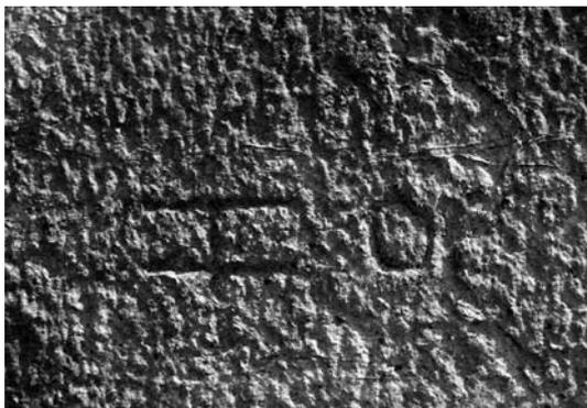
Abb. 33 »Ξ O«. Versatzmarke auf einem äußeren Quader der Nordwand.
